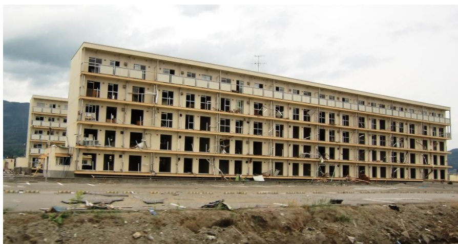
住居ビルの 4 階まで津波は襲っている。
